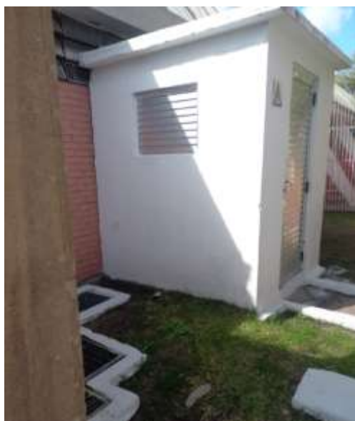
Sala Medição CEEE existente.
