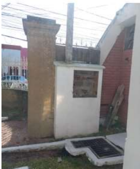
Figura 9 - Mureta e poste concreto a ser
