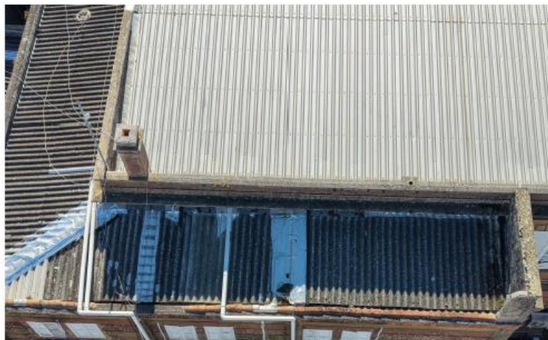
FIGURA 07 - VISTA GERAL DO TELHADO LATERAL
