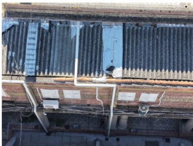
FIGURA 08 - VISTA APROXIMADA DO TELHADO LATERAL.
