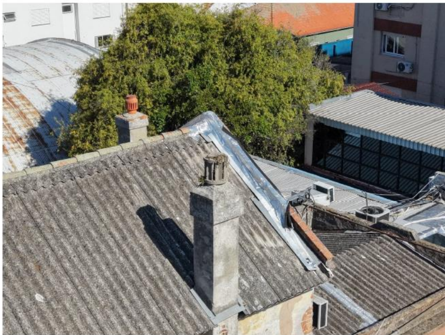
FIGURA 04 - VISTA LATERAL DO TELHADO DA TESOURARIA.
