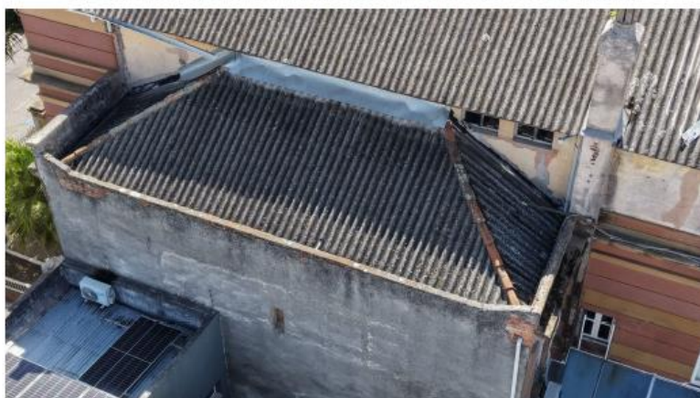
FIGURA 05 - VISTA GERAL DO TELHADO DO ALMOXARIFADO.
